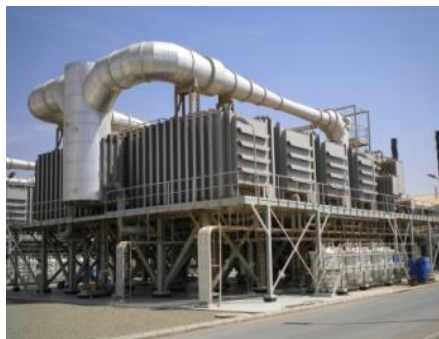
中東で活躍！省エネタイプ 陸上用海水淡水化装置 Reheat-type desalination plant for land use
