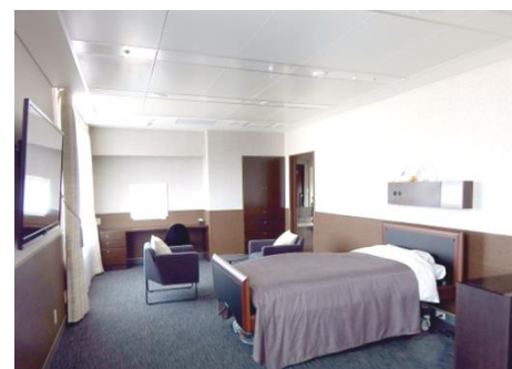
風のない快適な空間を実現、人工透析室で採用 放射パネル Radiant panel
