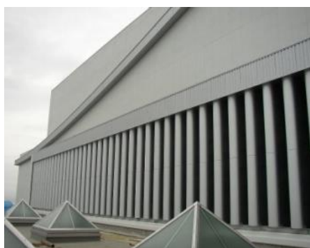
清掃工場で活躍 サイレンサー Silencer for municipal incineration plant
