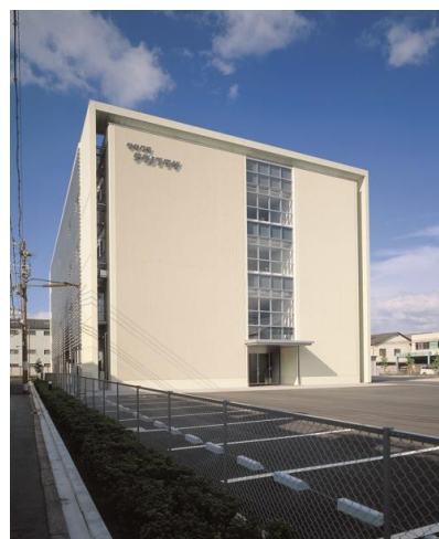
サクラ テクノプラザ Sasakura Technoplaza
